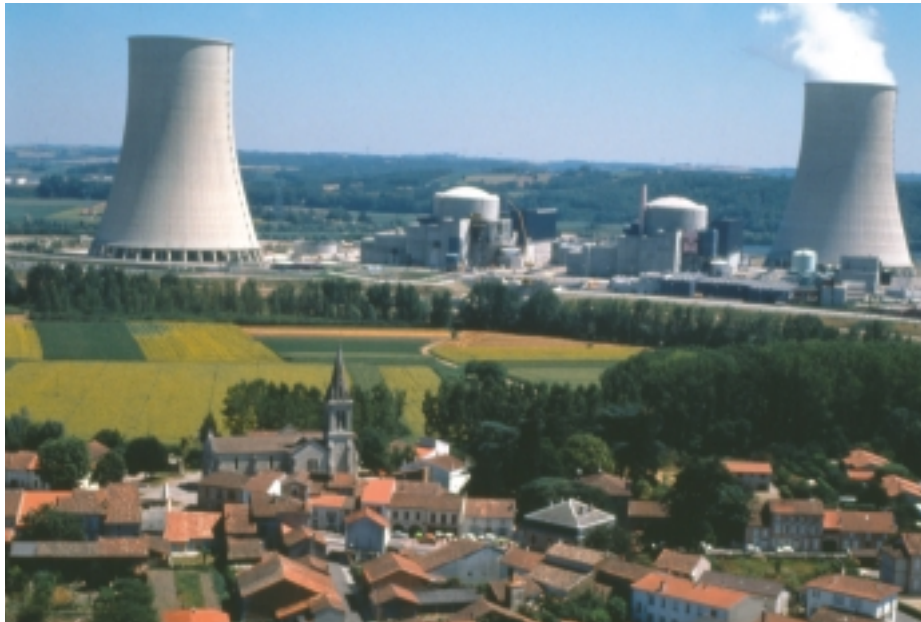
Centrale nucléaire de production d'électricité de Golfech
